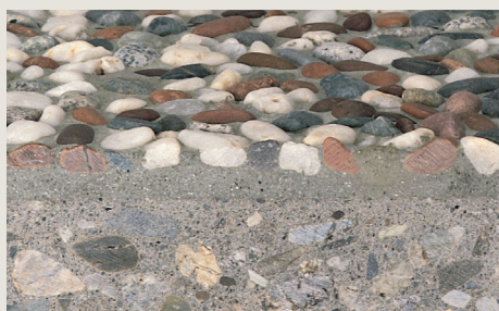
※パイブストーン施工部分
