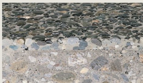
※テクストン施工部分
